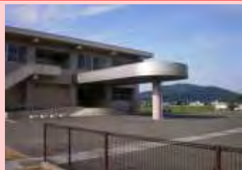
オフサイトセンター（福井県高浜原子力防災センター） (発電所からの距離約7km)
