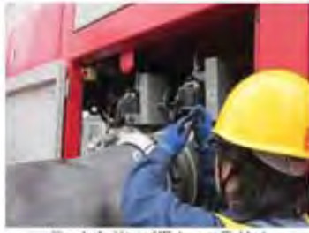
② 水中ポンプ用ホース取付け (屋外)
