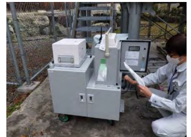
(写真 3-2) 可搬型ポスト設置
