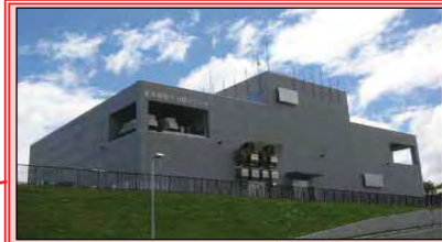
オフサイトセンター（共和町） （北海道原子力防災センター） 発電所からの距離約10km
