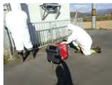
<非常用発電機による電源の確保>
