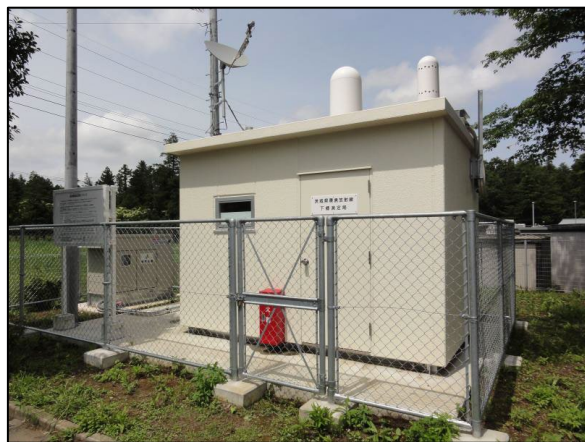
固定観測局【●局】 （非常用発電機装備）
