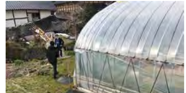
集落内の倒壊住居と退避時に使用されたビニールハウス
