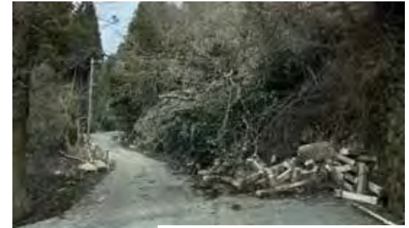
道路の被害状況(啓開済)
