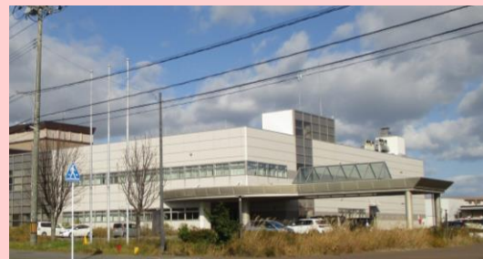
ろっかしよ ろっかしよむら 六ヶ所オフサイトセンター(六ヶ所村) 再処理施設からの距離約3km
