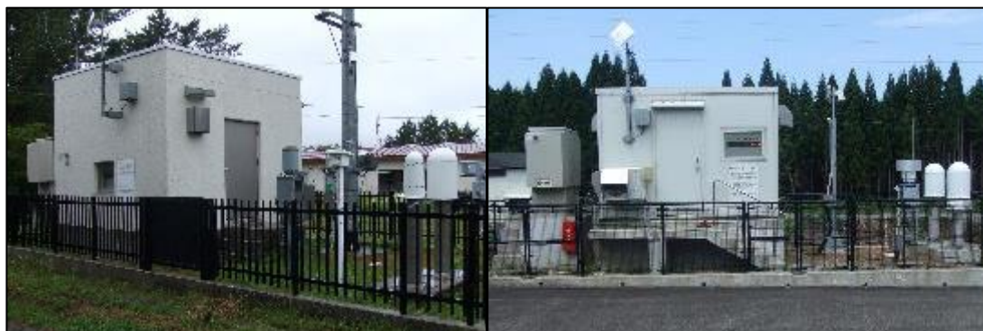
固定観測局【4局】 （非常用発電機装備）
