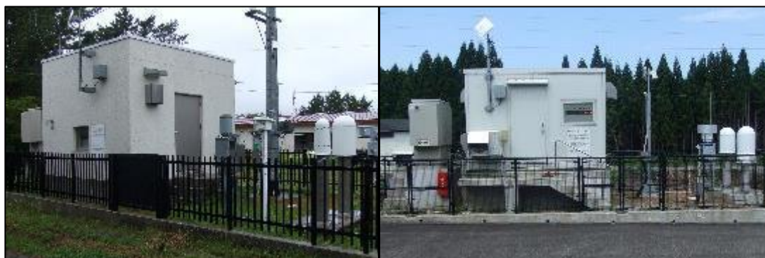
固定観測局【4局】 （非常用発電機装備）
