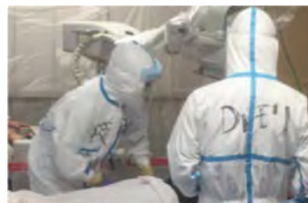
【線量測定、除染措置用施設の整備】
