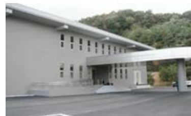
【浸水対策等の脆弱性対策を実施】
