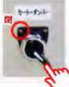
**4** 外気取入れバルブ (400φ閉鎖弁) を開にする
