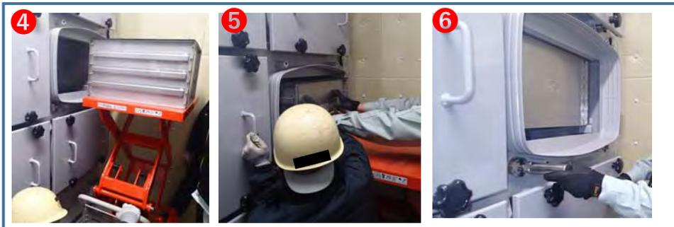
【参考例】汚染後のフィルタ交換方法（汚染拡大防止策）
