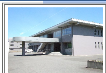
オフサイトセンター （福井県美浜オフサイトセンター）
