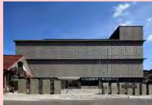
愛媛県オフサイトセンター (西予市) (発電所からの距離約24km)
