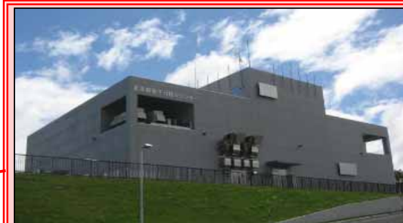
きょうわちよう オフサイトセンター (共和町) (北海道原子力防災センター) 発電所からの距離約10km
