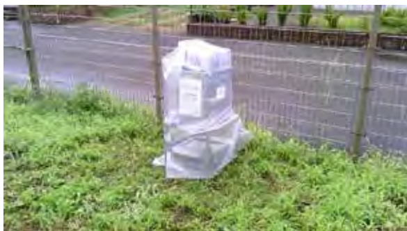
可搬型MPの設置
