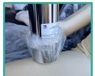
検出部の養生例
