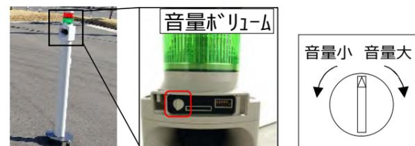
**Point** ゲートモニタ後方の要員に出力結果を伝達できる、必要最小範囲の音量に留めておく。
