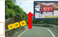
誘導標識の設置等
