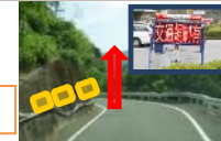
誘導標識の設置等
