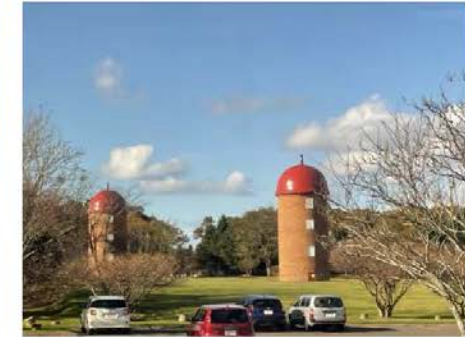
▲明治公園にある国内最大級の煉瓦造りサイロ
