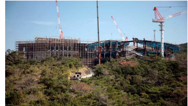
【写真②】第1研究棟・管理棟建設地 (2009年1月現在)
