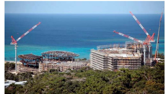
【写真③】丘陵側から第1研究棟・管理棟工事現場を望む (2009年1月現在)
