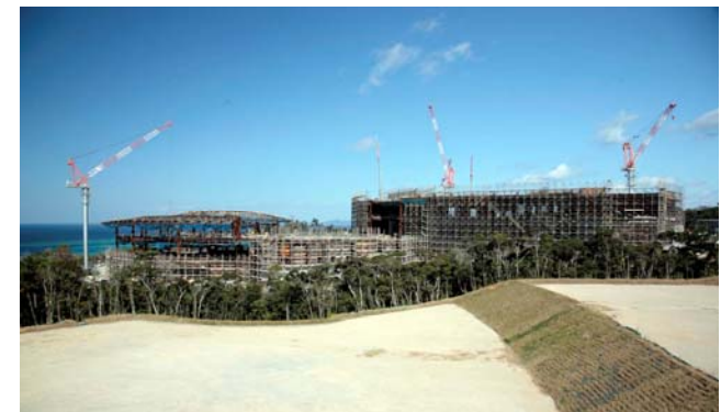
【写真④】第2・第3研究棟用地から第1研究棟・管理棟工事現場を望む(2009年1月現在)
