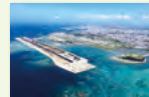
那覇空港第二滑走路など沖縄県内の社会基盤整備を推進しています。
