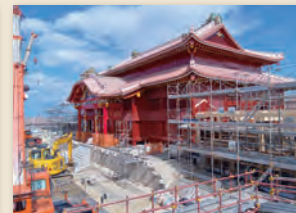
令和元年10月の火災により焼失した首里城について、令和4年11月に正殿の本体工事に着工しました。正殿の令和8年秋の復元に向けて政府として責任を持って取り組んでいます。
