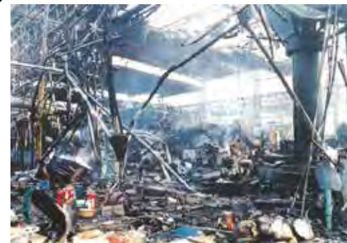
20MPaの空気タンクが爆発した事故 （出典：高圧ガス保安協会）
