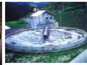
畜産環境対策施設
