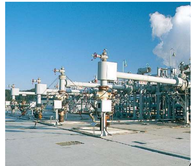
傾斜掘削基地（例）
