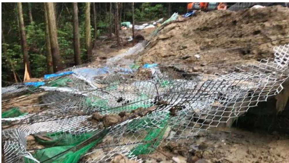
大分県杵築市 2020.5.27 メガソーラーの調整池崩落
