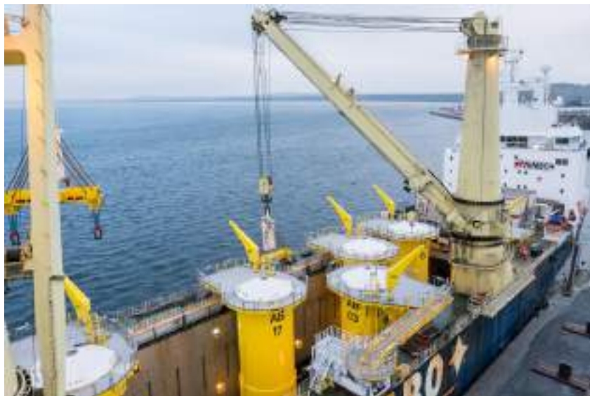
左：岸壁でのTPの荷揚（船舶クレーン使用）
