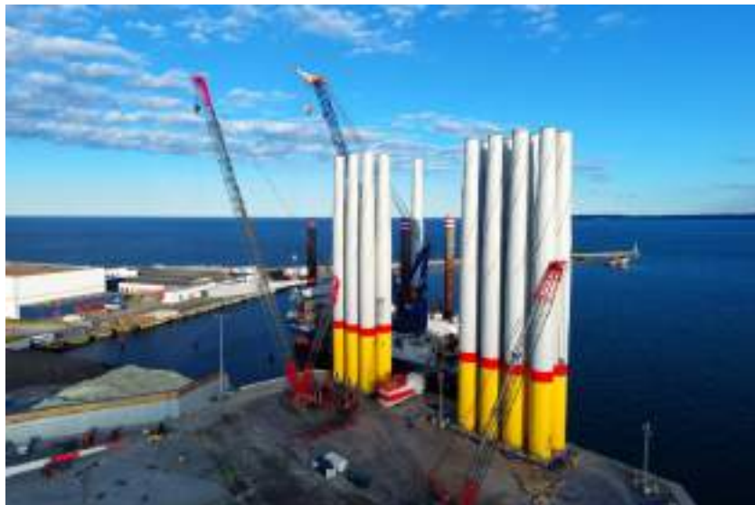
左：SEP船へのタワー、タービンの積込状
