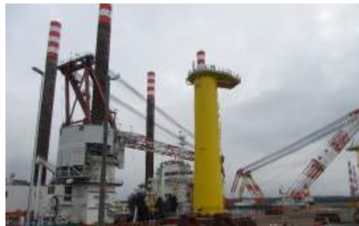
トランジションピース積み込みの様子
