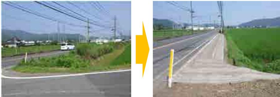
車道への雑草侵入を防ぐため、コンクリートを打設している
