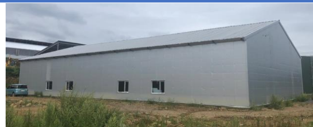
【排水処理施設 外観】
