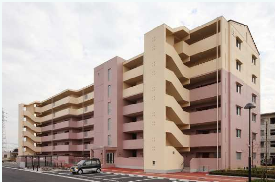
例：鉄筋コンクリート造
