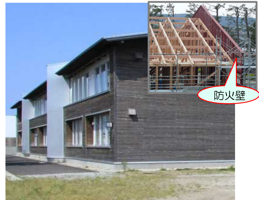
図：防火壁の設置例
