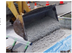
現場打ち舗装 施工状況
