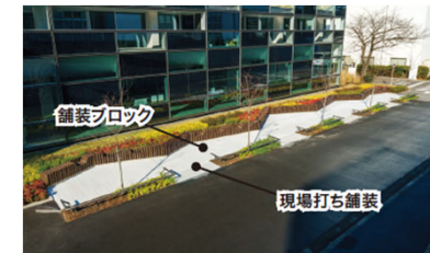
実証施工の様相 (当社技術センター)
