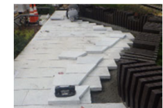
舗装ブロック 施工状況
