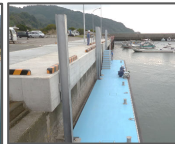
陸揚げの軽労化に資する浮体式係船岸の整備
