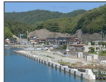
災害発生時の物資輸送拠点となる耐震強化岸壁の整備
