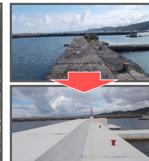
漁港施設の長寿命化対策
