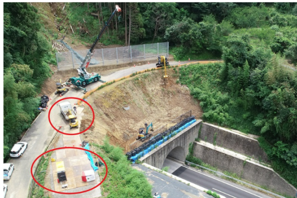
大分自動車道 のり面補修工事の様子 （赤枠上：実証試験で導入した電動化建機 赤枠下：水素混焼発電機）
