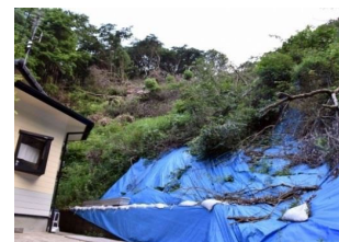
豪雨の度に土砂崩れが多発
