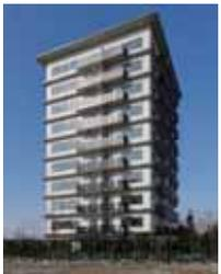
CLT・木質耐火部材を使用した10階建てマンション(2019年竣工)
