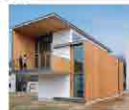
CLT工法による実験棟
