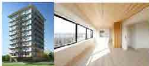
CLTを用いた10階建て共同住宅
