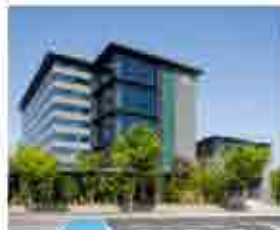
⑩松尾建設㈱本社ビル
