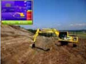
ICT建設機械の補助機能を活用し、オペレーターが建設機械を運転
