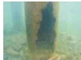
橋脚水中部の断面欠損
