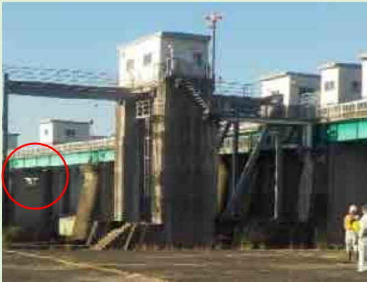
頭首工点検における UAV活用状況
