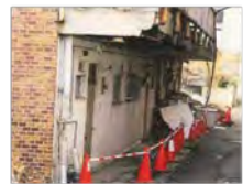
(建物の傷みが著しく外壁の剥落等が生じた事例)
