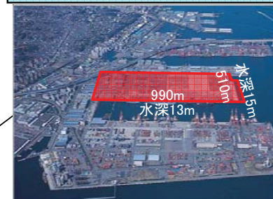
横浜港本牧ふ頭BC突堤間CT
