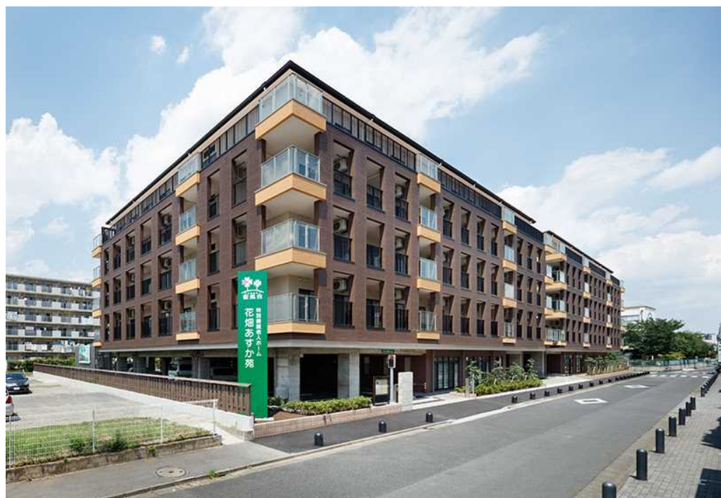
写真提供：三井ホーム
