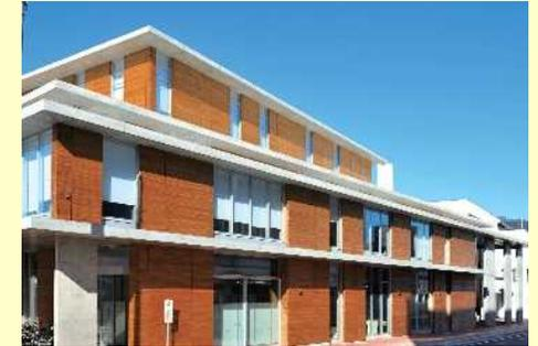
耐火構造として防火被覆を設けたことにより、化粧材に木材を張るなどの措置が必要となった例
