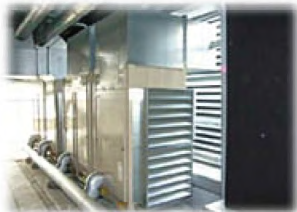
室外機（標準性能サイレンサー）
