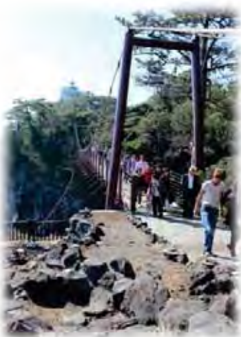
↑ 城ヶ崎 門脇吊り橋
