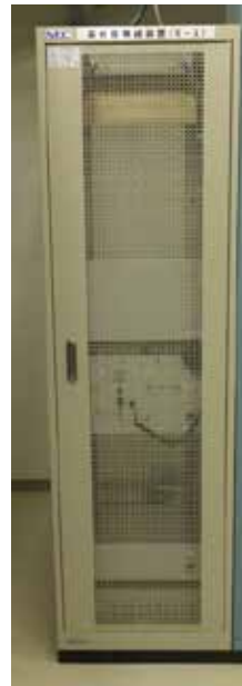
基地局装置 (全国約400局整備予定)
