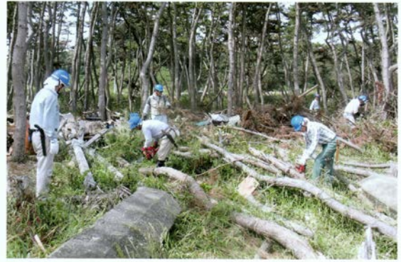
震災後の七ヶ浜での倒木とガレキの撤去作業
